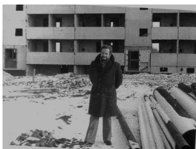
Fot. Prezes L.Śliwiński na placu budowy ( Frelichowskiego 4 )
