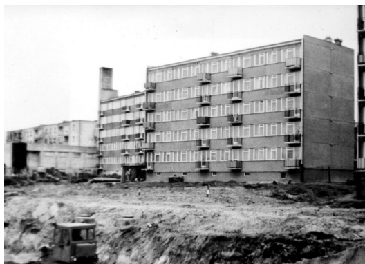
Fot. Prace przy wzmocnianiu gruntu pod budynki św. Jana 16 i P. Skargi 15
